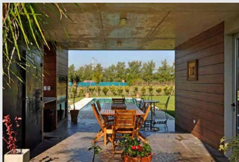
“De cara al entorno descampado que ofrece esa zona del barrio, el viento era un obstáculo a la hora de elegir la materialidad y las aberturas –indica el arquitecto Pieretto– por lo que se optó por una construcción mixta con estructura de hormigón, en algunos casos visto, ladrillos cerámicos huecos *Clima Block*, y *siding* exterior *Superboard* símil madera. Las aberturas son de aluminio anodizado con puente térmico de alta prestación y vidrios DVH. La calefacción se resolvió con piso radiante”.
