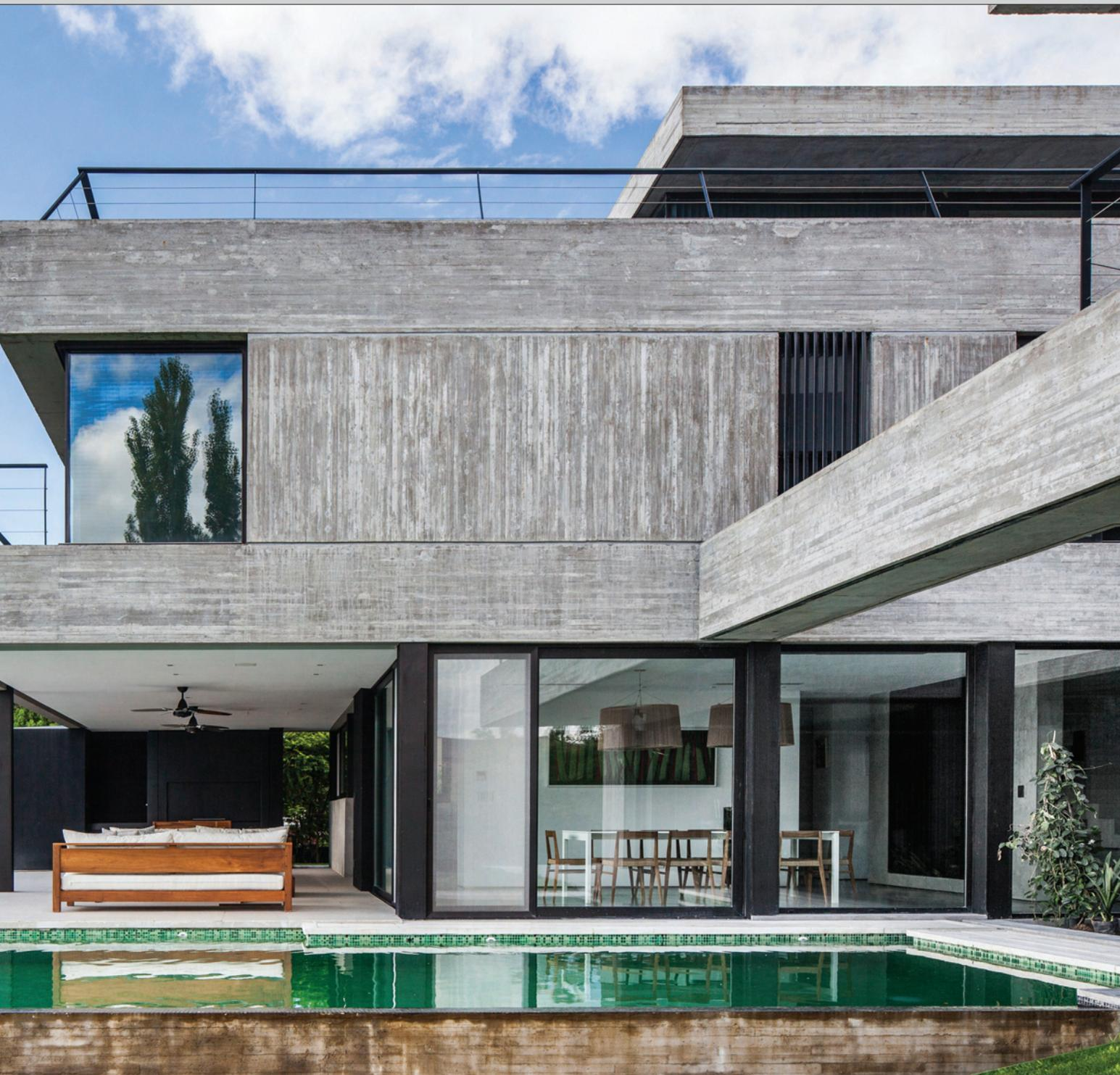
La decisión de utilizar hormigón visto, tanto en el exterior como en el interior, responde a que los propietarios deseaban una vivienda funcional y sin exigencias de mantenimiento. Los pisos son de hormigón alisado, excepto en los dormitorios, donde se colocaron pisos de madera de incienso.
