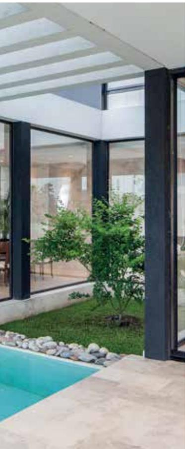
En la volumetría no aparecen ventanas o vanos; se busca potenciar la horizontalidad de la casa con la desmaterialización de los muros y los cerramientos verticales, resueltos con grandes paños de vidrio o con materiales livianos y envarillados metálicos.
